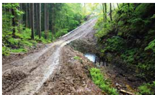
作業道の土砂で埋まった取水池
