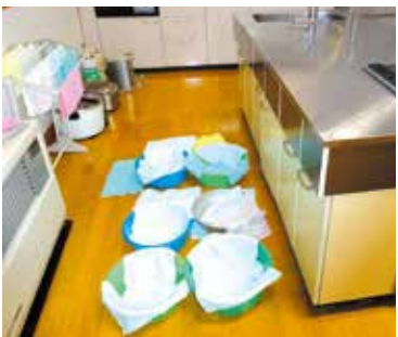
冬期間の水漏れ(台所)
