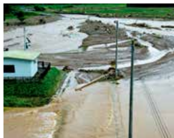
水道管が破損 (五反沢浄水場周辺)
