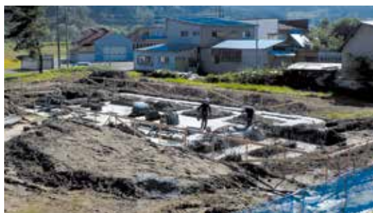
村営アパートの建設工事が始まる
